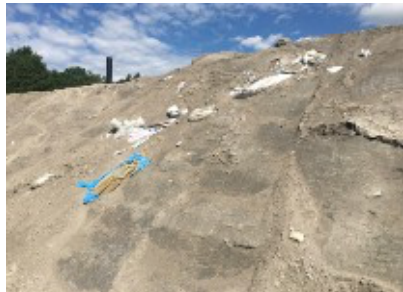
Recouvrement trop faible! Excavation
