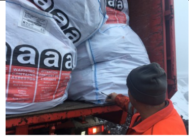
Il est interdit de pénétrer dans la zone de montage sans masque de protection FFP3.
