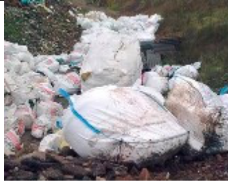
L'installation de déchets d'amiante sans recouvrement immédiat est interdite
