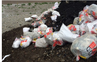
Stockage ouvert et prolongé de déchets d'amiante, exposés aux intempéries - interdit
