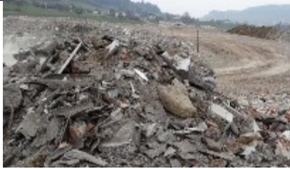
Interdit stockage ouvert d'amiante-ciment
