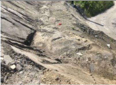
Site de pose préparé (terrasse)
