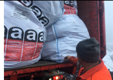
Betreten des Einbaubereichs ohne Schutzmaske FFP2 ist verboten
