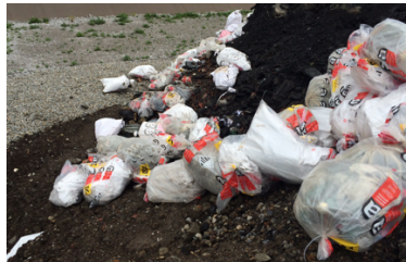
Offene, längere Lagerung von Asbestabfällen, werden der Witterung ausgesetzt - verboten
