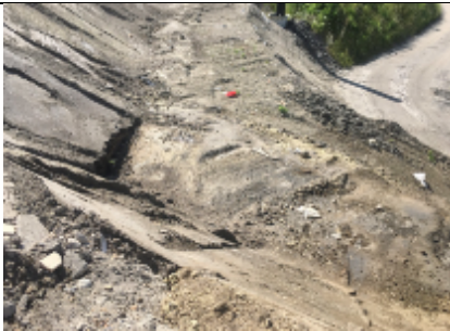
Vorbereitete Einbaustelle (Terrasse)
