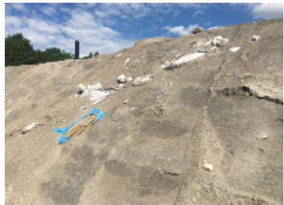
Zu geringe Überdeckung!
