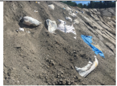
Zu geringe Überdeckung!
