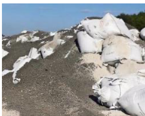
Havarie bei unsachgemässer Deponierung von Asbestabfällen
