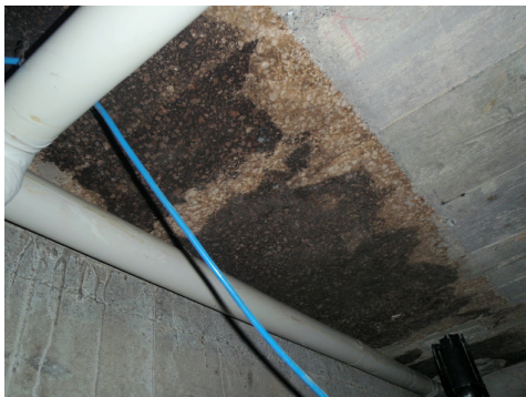
Isolamento in sughero bituminoso (ponte termico). L'isolamento è stato posato nel cassero della soletta prima del getto del calcestruzzo.
