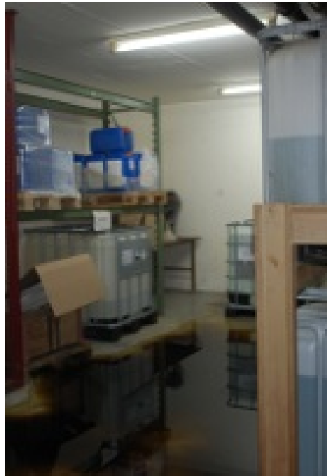
Incendio in un'officina galvanica, acqua di spegnimento contaminata da olio al piano interrato, Markus Durrer, IBH Expertenstelle Chur
