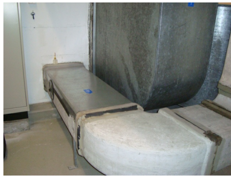
Canale di ventilazione in cemento amianto, Carbotech
