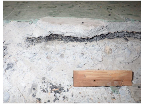
Riempimento di IPA sotto il massetto, Gartenmann Engineering
