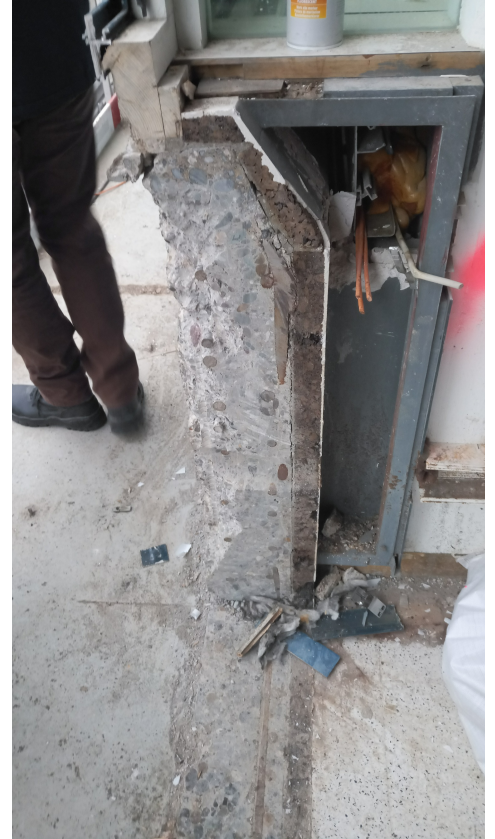
Sughero catramato in una facciata, SCS
