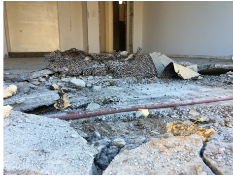
IPA, stuoia di scarto di sughero sotto il sottofondo, Gysi Leoni Mader
