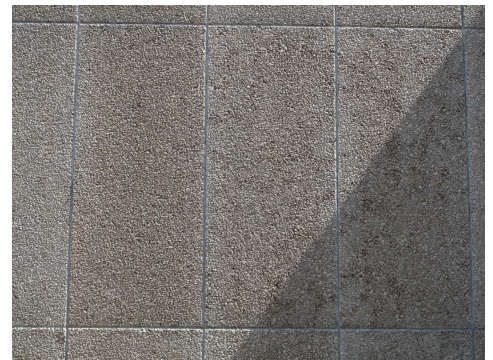
Masse di sigillatura dei giunti, calcestruzzo lavato, Gebäudediagnostik Siegwart
