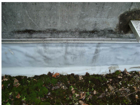
Manto impermeabile sintetico contenente amianto (tipo Hypalon). Lato superiore. (Foto Carbotech)
