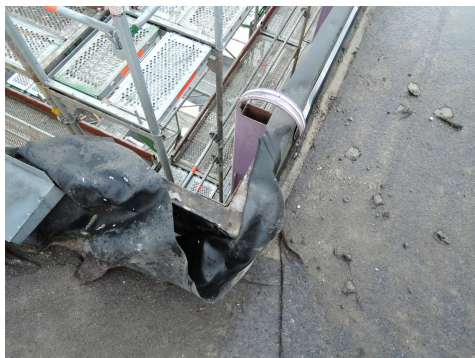
Manto impermeabile sintetico per tetti (tipo Hypalon®). (Foto: Arcadis Svizzera)
