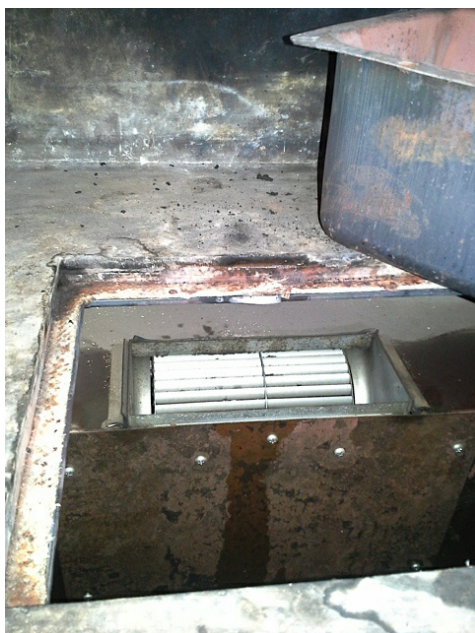
Caminetto con guarnizione/tessuto contenente amianto nel cassetto per la raccolta della cenere (Foto Bafob GmbH)
