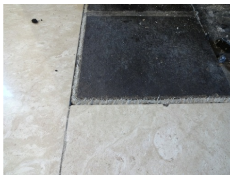
Corda di amianto tra la camera di combustione e la mensola del caminetto, Carbotech
