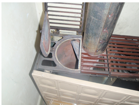
Stufa a olio con corda contenente amianto
