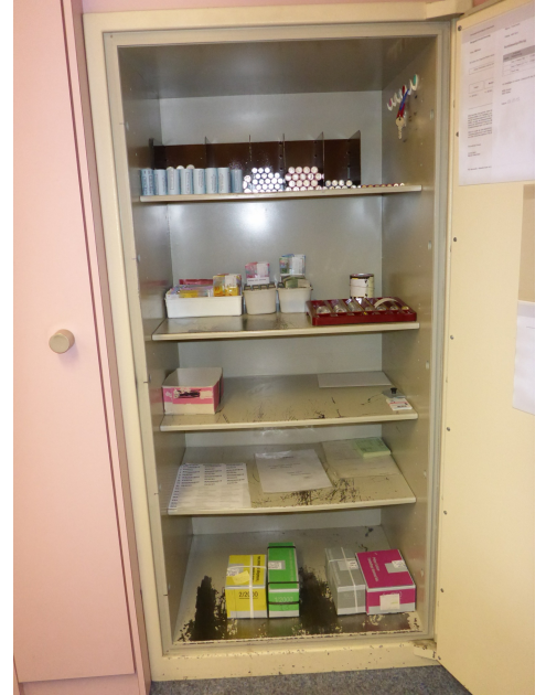
Cassaforte munita di un pannello leggero contenente amianto (prima dello smontaggio del pannello di rivestimento interno). (Foto: Ecosens AG, Wallisellen)
