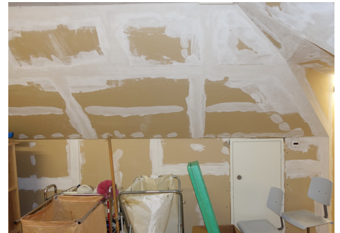
3. Stuccature delle giunzioni tra elementi in cartongesso. (in questo caso senza amianto). (Foto Carbotech AG)
