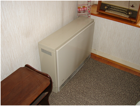
Stufa elettrica ad accumulo della marca AEG, Carbotech
