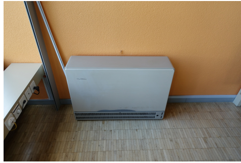
Stufa elettrica ad accumulo della marca Witte, Carbotech
