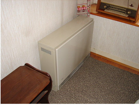
Stufa elettrica ad accumulo contenente amianto (apparecchio chiuso). (Foto Carbotech)
