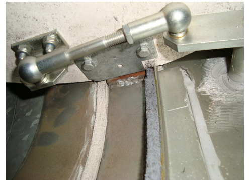
Primo piano di una guarnizione di battuta Litaflex in una serranda tagliafuoco, Carbotech
