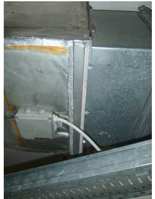
Pannelli leggeri tra i condotti di aerazione.
