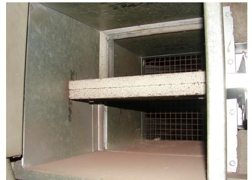
Serranda tagliafuoco con guarnizione di battuta in Litaflex, Carbotech
