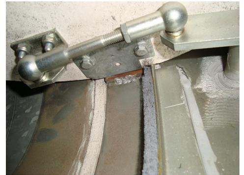
Primo piano di una guarnizione di battuta Litaflex in una serranda tagliafuoco, Carbotech
