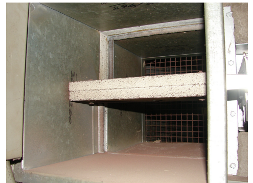
Serranda tagliafuoco con guarnizione di battuta in Litaflex, Carbotech
