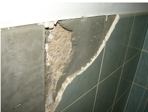
Secondo lo stato attuale delle conoscenze, la malta utilizzata per l'incollaggio puntuale delle piastrelle con la tecnica di posa "dot and dab tiling" non
