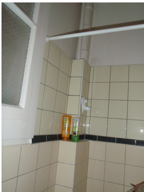
Piastrelle rinnovate sopra una vasca da bagno, SCS
