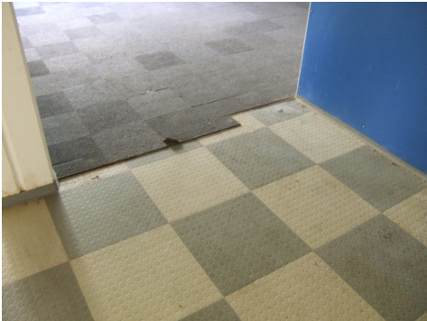
Rivestimento vinilico per pavimenti: questo tipo di materiale non è suscettibile di contenere amianto
