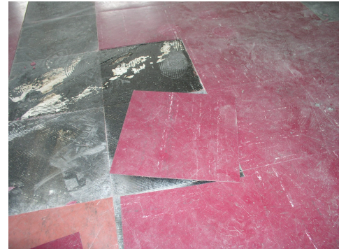
Piastrelle floorflex rosse con adesivo bituminoso, Suva
