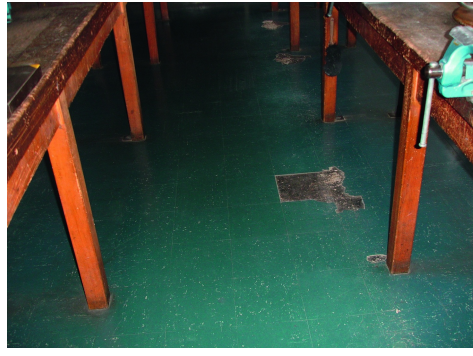
Floorflex verde con adesivo bituminoso, Suva
