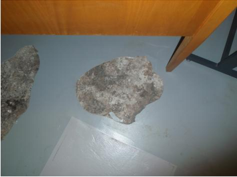
Rivestimento di pavimenti in resina sintetica contenente amianto nello strato di adesivo.
