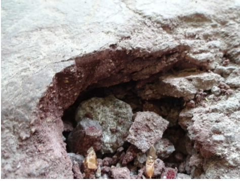
Pavimento in legno-cemento contenente amianto.
