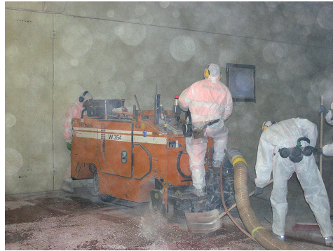
Rimozione del massetto in magnesite, Suva
