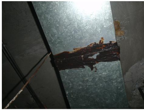
Giunto di un impianto di aerazione sigillato con colla contenente amianto (bitume?).
