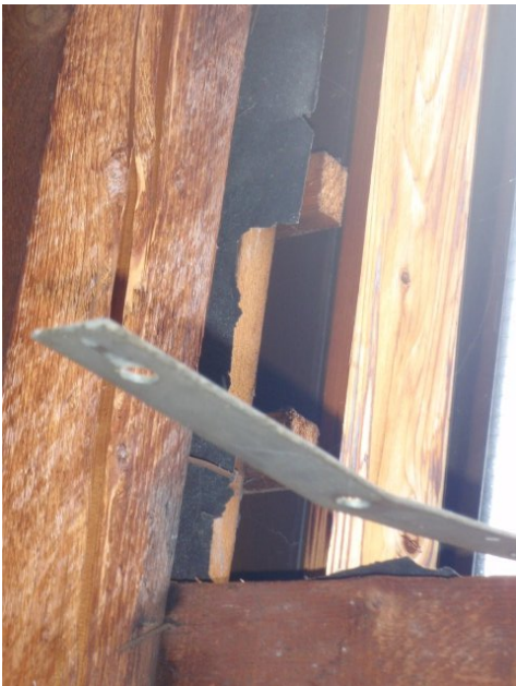
Cartone bitumato (in questo caso senza amianto).
