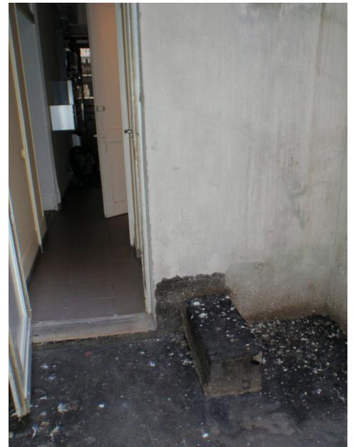
Guarnizione bituminosa con amianto nel cortile interno.
