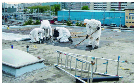
Lastre di bitume contenenti amianto, Suva
