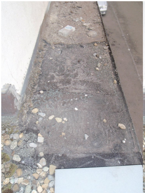
Impermeabilizzazione bituminosa sul tetto. Qui, non era il manto bituminoso a contenere amianto, ma solo la colla.
