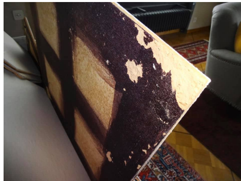
Pannello per controsoffitto con colla contenente amianto, Solgeo
