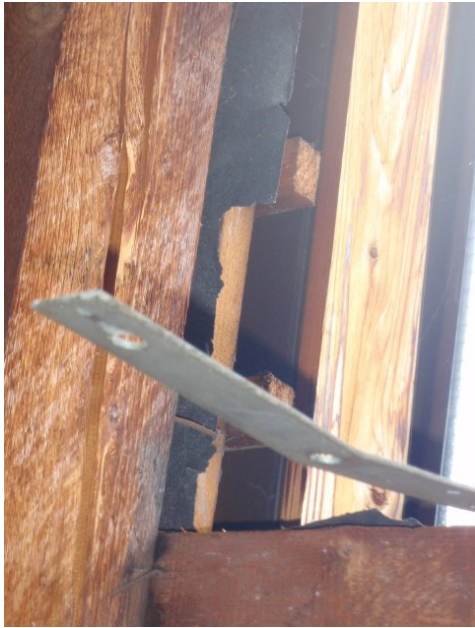
Cartone bitumato (in questo caso senza amianto).
