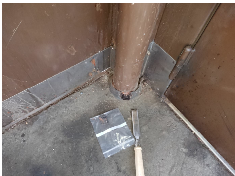
Lastre di bitume contenenti amianto, Suva
