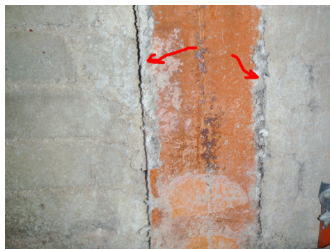
Trave in acciaio non pulita sufficientemente. Tali elementi devono essere di nuovo bonificati.
