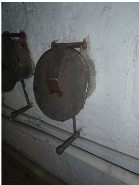
Bocchette d'ispezione del condotto dei fumi contenenti amianto.
