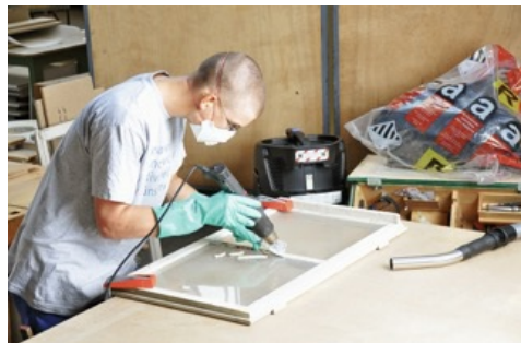
Rimozione di un mastice contenente amianto, procedimento a caldo, Suva
