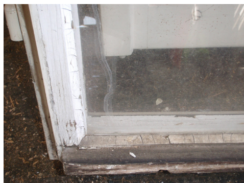
Mastice di finestre in un telaio in legno con doppi vetri, Suva
