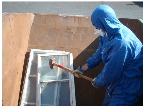
Rimozione dei vetri di finestre con mastice contenente amianto all'aperto, Suva
