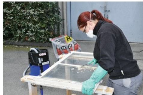
Rimozione di un mastice contenente amianto con attrezzi manuali, Suva
