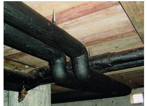
Peinture bitumineuse sur isolation de conduites, Suva
