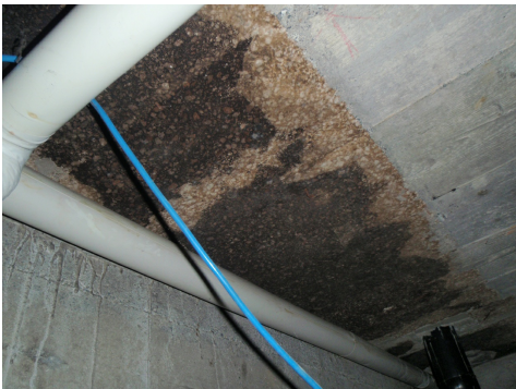
Isolation en liège bitume (pont thermique). L'isolation a été placée dans le coffrage avant la pose du béton.
