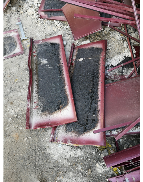
Plaque de façade avec enduit bitumineux contenant de l'amiante. Photo: C. Campoarmor, Arcadis Schweiz AG
