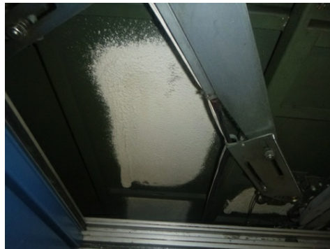
Revêtement d'insonorisation dans une cabine d'ascenseur, Carbotech
