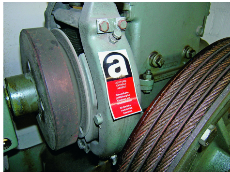
Plaquettes de frein amiantées
