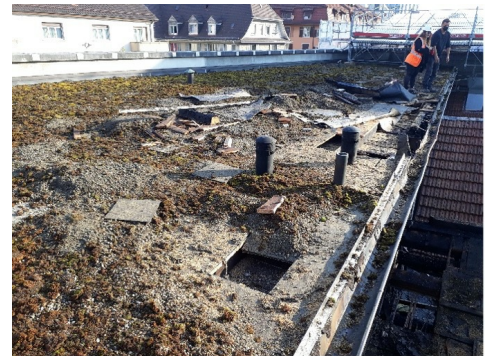
« Ouvertures de ventilation » dans le toit réalisées par le service du feu, Markus Durrer, IBH Expertenstelle Chur
