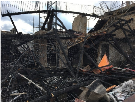
« Ouvertures de ventilation » dans le toit réalisées par le service du feu, Markus Durrer, IBH Expertenstelle Chur
