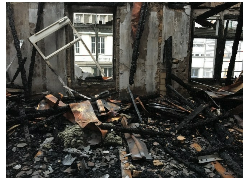
Fractions grossières et fines après un incendie, Markus Durrer, IBH Expertenstelle Chur
