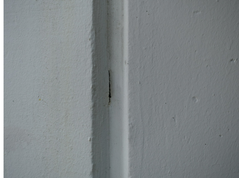
Masse d'étanchéité des joints, Gebäuediagnostik Siegart
