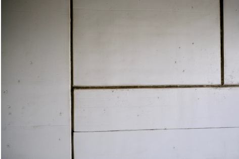
Masse d'étanchéité des joints, Gebäuediagnostik Siegart
