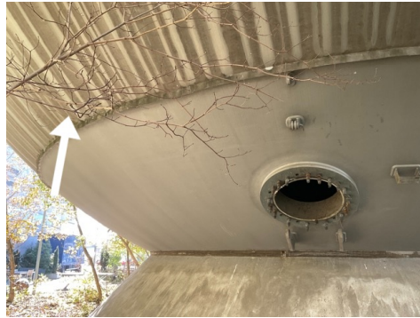
Peinture sur un réservoir de gaz à haute pression, TFB Technik und Forschung im Betonbau
