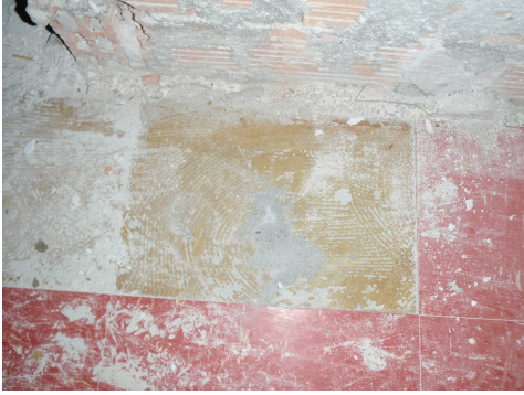
Colle synthétique sous une dalle en vinyle (ici, sans amiante)
