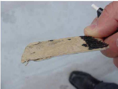
Photo présentant la couche amiantée (semblable au cushion vinyle). Photo: Carbotech.
