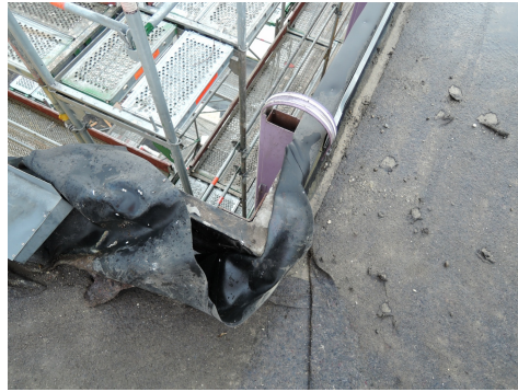
Etanchéité de toit Hypalon (Photo: Arcadis Schweiz)
