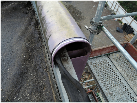
Etanchéité de toit Hypalon (Photo: Arcadis Schweiz)
