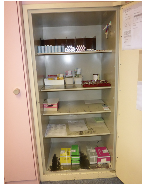
Coffre-fort avec panneaux légers contenant de l'amiante (avant démontage du volet intérieur). Photo: Ecosens AG, Wallisellen
