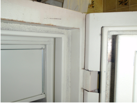
Coffre-fort avec étanchéité en tissu amianté. Photo, Picadus, S. Schneebeili
