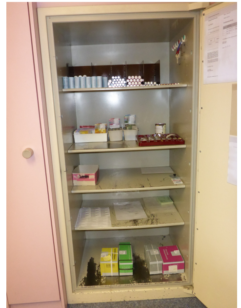
Coffre-fort avec panneaux légers contenant de l'amiante (avant démontage du volet intérieur). Photo: Ecosens AG, Wallisellen
