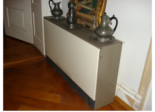
Chauffage électrique à accumulation, Carbotech
