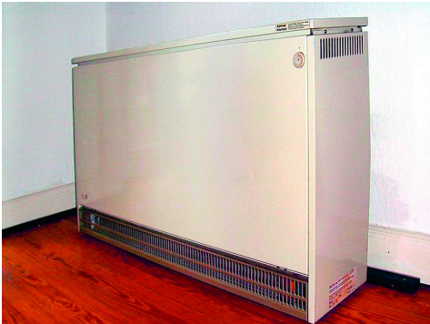
Chauffages électriques à accumulation
