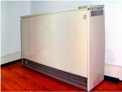
Chauffages électriques à accumulation
