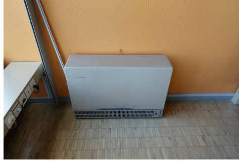
Chauffage électrique à accumulation de la marque Witte, Carbotech
