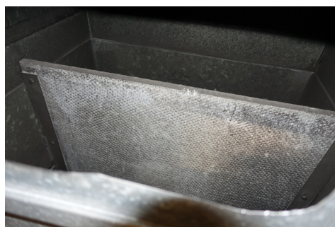
Clapet coupe-feu avec lame en amiantement, Carbotech
