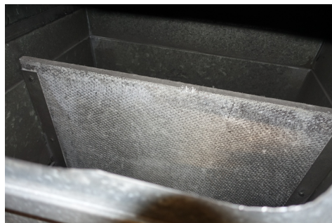
Clapet coupe-feu avec lame en amiantement, Carbotech
