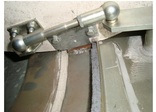
Gros plan d'un joint d'étanchéité Litaflex dans clapet coupe-feu, Carbotech
