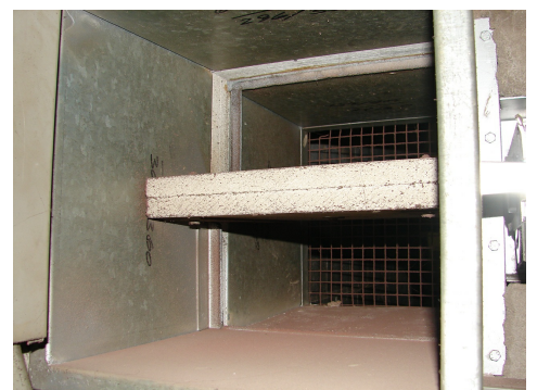
Clapet coupe-feu avec joint d'étanchéité en Litaflex, Carbotech
