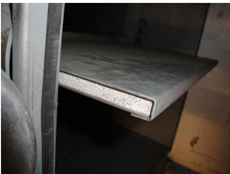
Clapet coupe-feu avec lame avec panneau léger, Carbotech
