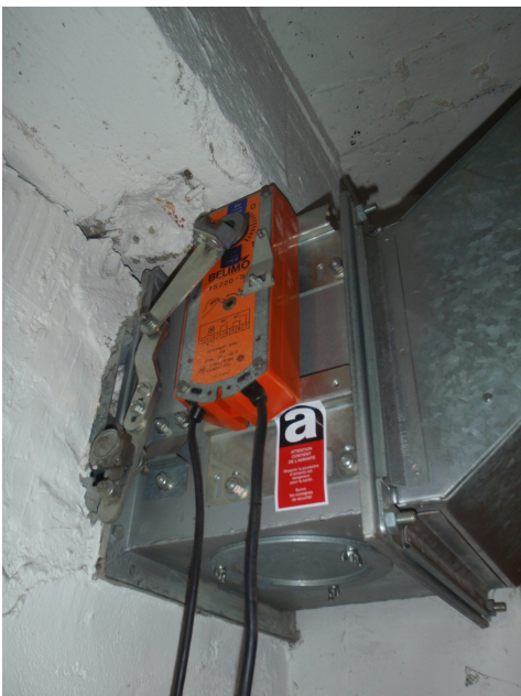
Clapet coupe-feu. Le clapet se trouve à l'intérieur de l'appareil.
