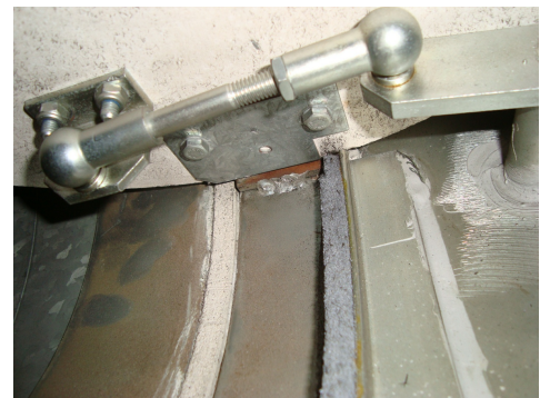
Gros plan d'un joint d'étanchéité Litaflex dans clapet coupe-feu, Carbotech
