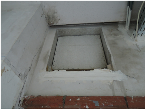
Panneau léger agrafé sur un clapet coupe-feu, Arcadis Schweiz
