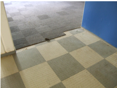
Ce type de dallette n'est pas susceptible de contenir de l'amiante.
