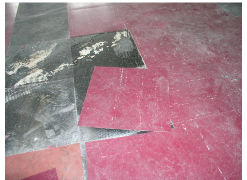
Dalletes Floorflex rouges avec colle bitumineuse, Suva
