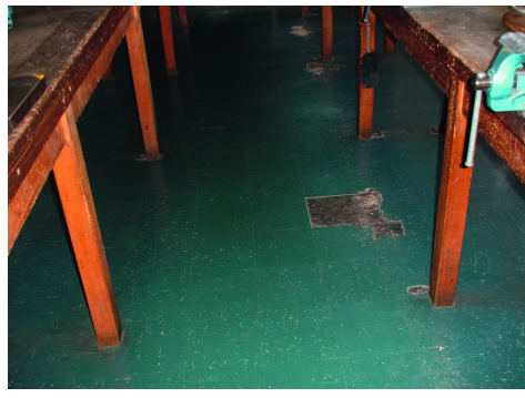
Floorflex vert avec colle bitumineuse, Suva
