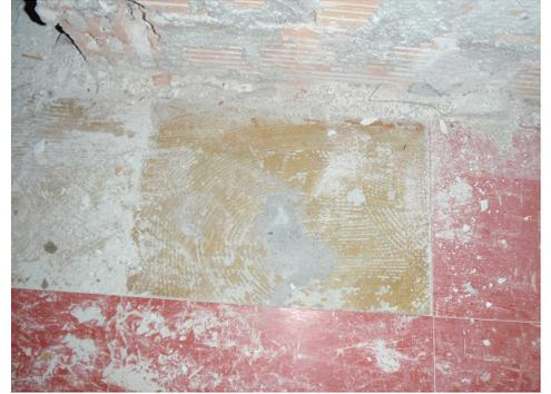
Colle non bitumineuse sous dallette vinyle. Celle-ci peut également contenir de l'amiante.
