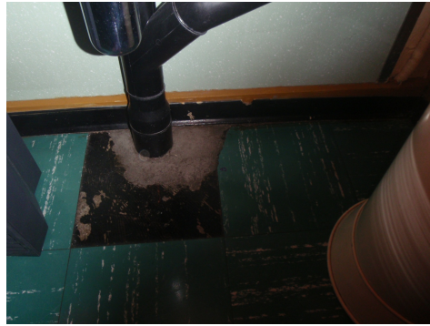
Dalles de sol en vinyle. Colle bitumineuse en dessous – également amiantée.
