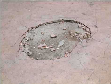
Chape à base de magnésite, Suva
