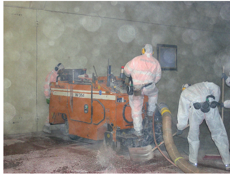
Retrait de la chape à base de magnésite, Suva
