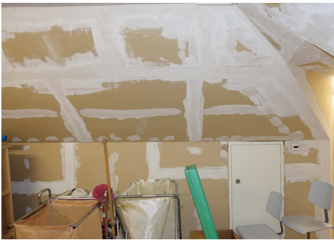
Enduit sur du plâtre cartonné avant crépissage (ici, non amianté). Photo de Carbotech AG
