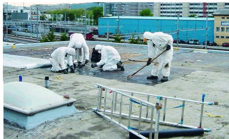
Lé de bitume contenant de l'amiante, Suva
