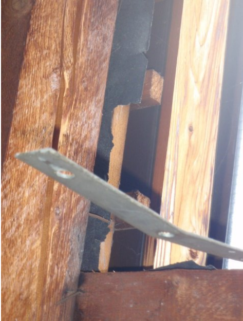
Carton bitumineux (non amianté dans ce cas)
