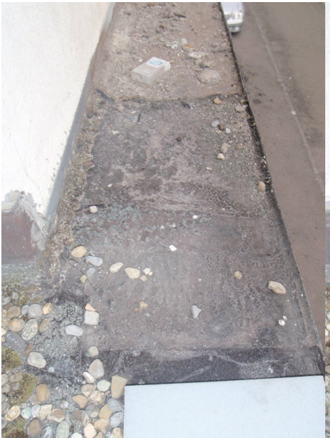
Etanchéité bitumineuse sur un toit. Ici, le carton de toiture ne contient pas d'amiante, seule la colle en contient.
