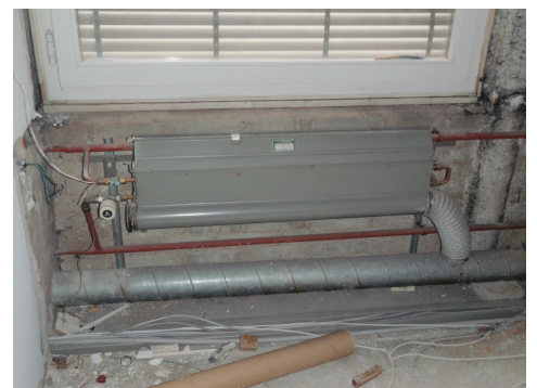
Amiante floqué utilisé comme isolation thermique sur des poutres en acier (à droite du chauffage/de la ventilation)
