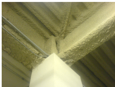
Flocage de protection contre les incendies - dans ce cas, sans amiante (date plus récente)
