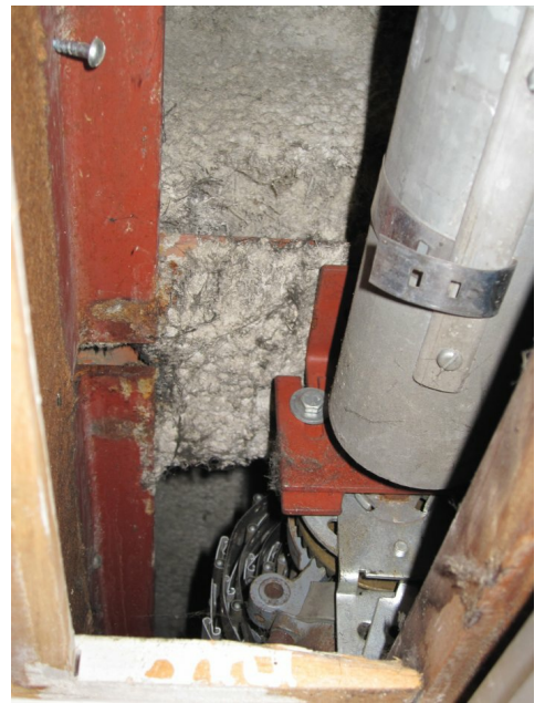
Amiante floqué dans des caissons de stores. Photo SC+P Sieber Cassina + Partner AG
