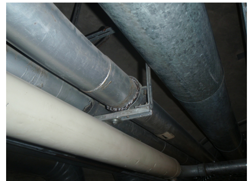
Bande/tissu amiantée sous une bride de tuyau
