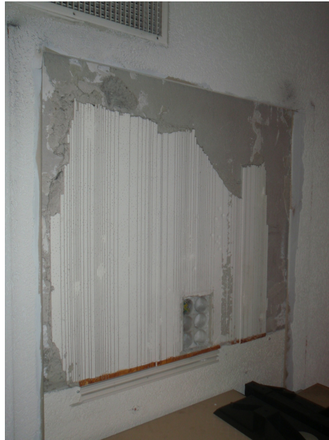
Isolation acoustique sur les murs, déjà partiellement retirée. Le matériau est généralement gris à l'intérieur.
