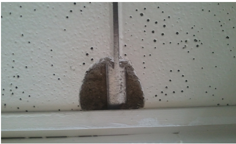
Faux plafond avec plaques acoustiques après échantillonnage.
