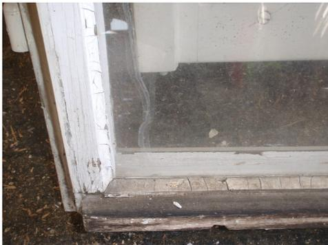
Mastic de fenêtres d'un cadre en bois avec double vitrage, Suva
