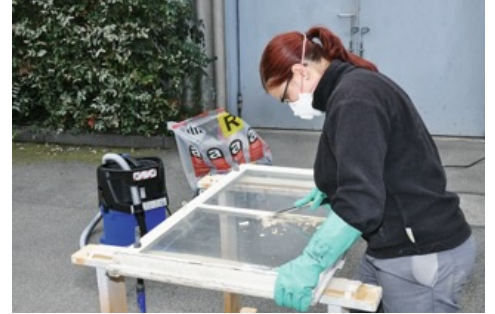
Retrait d'un mastic contenant de l'amiante avec des outils manuels, Suva
