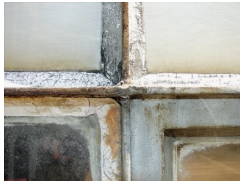
Mastic de fenêtres d'un cadre métallique, Suva
