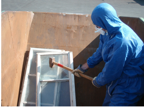
Séparation des vitrages de mastic de fenêtre amianté lors de travaux de démolition en plein air, Suva
