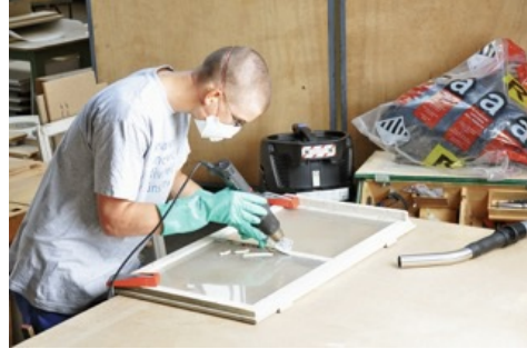
Retrait d'un mastic contenant de l'amiante, procédé thermique, Suva
