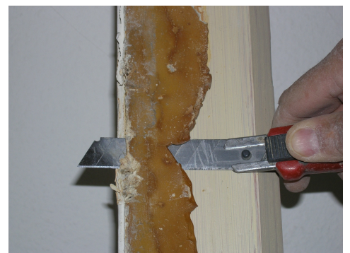
Retirer la masse d'égalisation, Suva
