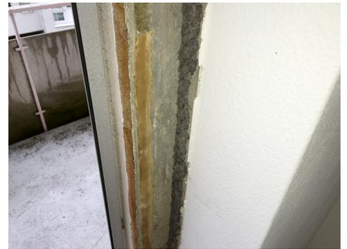
La masse d'égalisation est parfois insérée profondément entre le dormant (cadre de fenêtre) et la maçonnerie. Elle peut être accessible depuis l'extérieur en retirant le crépi de façade. Photo A. Pfister, Jäckli AG
