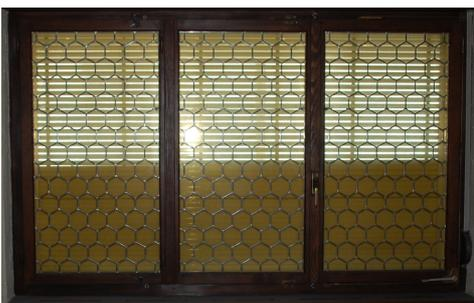
Vitreaux avec mastic amianté. Si les verres synthétiques étaient directement en contact avec le mastic, celui-ci ne
