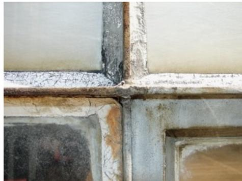
Mastic de fenêtres d'un cadre métallique, Suva
