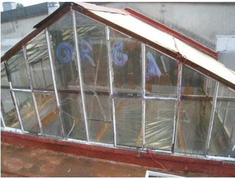
Toiture en verre avec mastic de fenêtre amianté. Photo Picadus, S. Schneebeli
