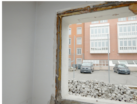
La masse d'égalisation est parfois insérée profondément entre le dormant (cadre de fenêtre) et la maçonnerie. Elle peut être accessible depuis l'extérieur en retirant le crépi de façade. Photo A. Pfister, Jäckli AG
