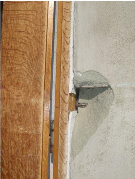
Masse d'égalisation contenant de l'amiante (entre le cadre de porte et la maçonnerie).
