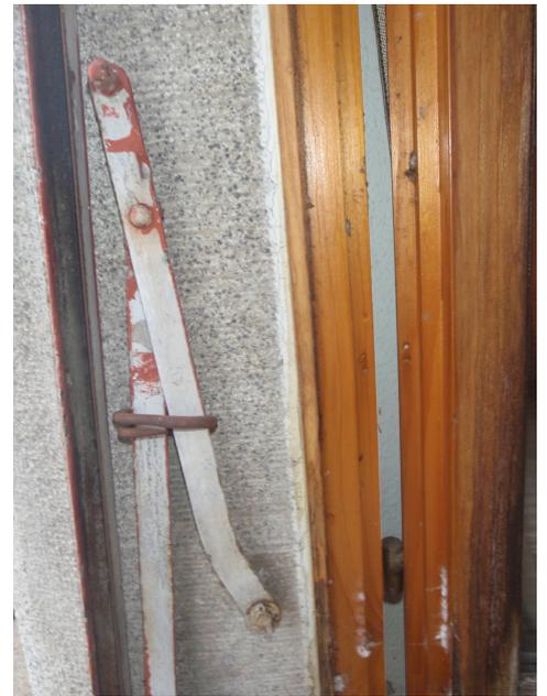
Masse d'égalisation contenant de l'amiante (entre le cadre de fenêtre et la maçonnerie)
