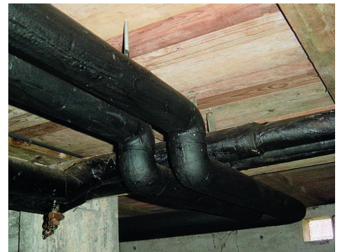
Bituminöser Anstrich auf Leitungsdämmung, Suva
