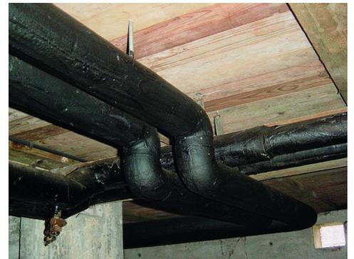
Bituminöser Anstrich auf Leitungsdämmung, Suva
