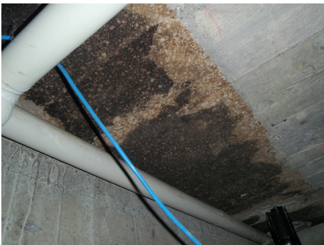
Kork-Bitumen-Isolation (Wärmebrücke). Die Isolation wurde noch vor dem Betonieren in die Schalung gelegt.
