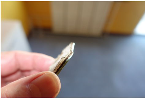
Bodenbelag mit asbesthaltiger Kork-Schicht (Amphibol-Asbest). Ist als schwach gebunden einzustufen. Photo: Carbotech AG.
