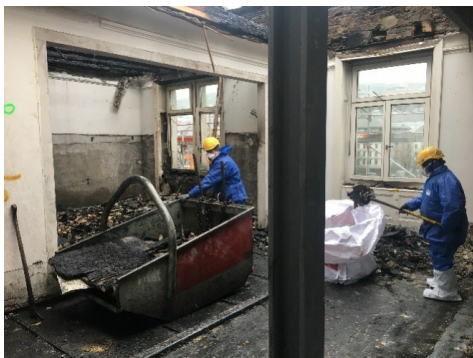
Aufräumarbeiten der Gross- und Kleinfraktion, Markus Durrer, IBH Expertenstelle Chur
