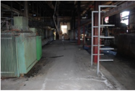
Brand in einem Galvanisierungswerk, Markus Durrer, IBH Expertenstelle Chur
