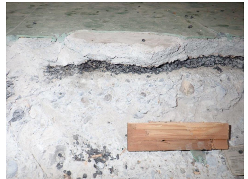
PAK-Schüttung unter Unterlagboden, Gartenmann Engineering
