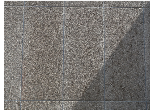
Fugendichtungsmasse Waschbeton, Gebäudediagnostik Siegwart
