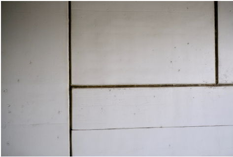
Fugendichtungsmasse, Gebäudediagnostik Siegwart
