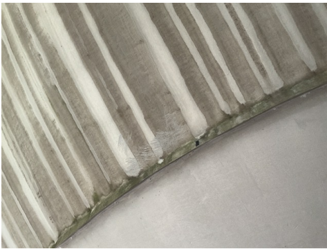
Anstrich an einem Gashochdruckspeicher, TFB Technik und Forschung im Betonbau
