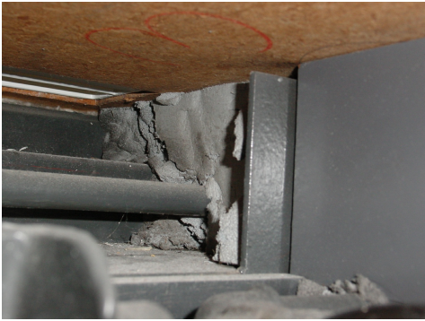
Litaflex als Brandabschottung bei Mauerdurchführung von Heizungsrohren im Brüstungsbereich. Photo: Carbotech AG
