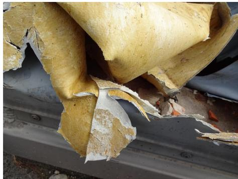
Detail der beschädigten Kamin-Abdeckung aus asbesthaltigem Hypalon. Photo: J. Meyer, Solgeo AG
