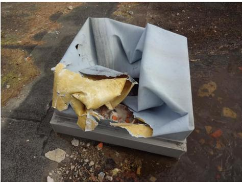
Beschädigte Kaminabdeckung aus Hypalon. Das Dach selber war ebenfalls mit Hypalon abgedeckt (unter der Bitumen-Pappe, die neueren Datums ist). Photo: J. Meyer, Solgeo AG
