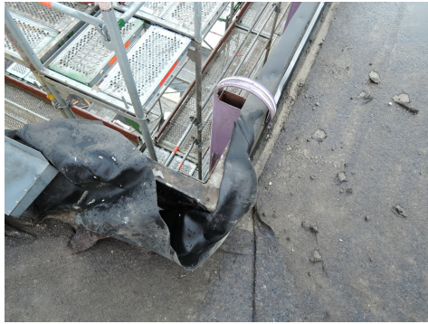
Hypalon Dachabdichtung (Photo: Arcadis Schweiz)
