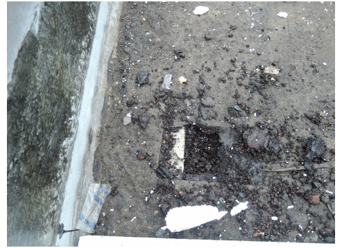
Hypalon Dachabdichtung (Photo: Arcadis Schweiz)
