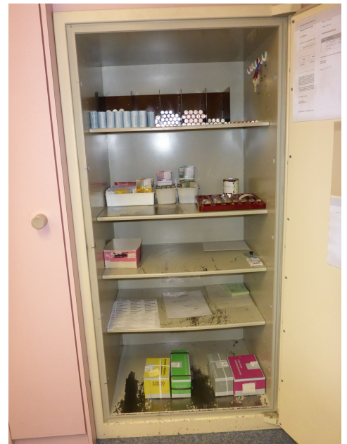
Tresor mit asbesthaltiger Leichtbauplatte (vor Demontage der inneren Blende). Photo: Ecosens AG, Wallisellen
