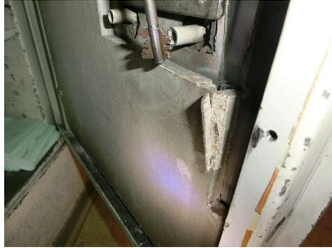
Asbesthaltige Leichtbauplatte LAP in Tresor. Diese lassen sich meist relativ einfach im offenen Zustand durch Abschrauben der inneren Blende kontrollieren. Ebenfalls können Proben mit einem spitzen Werkzeug aus den Tablarlöchern entnommen werden.
